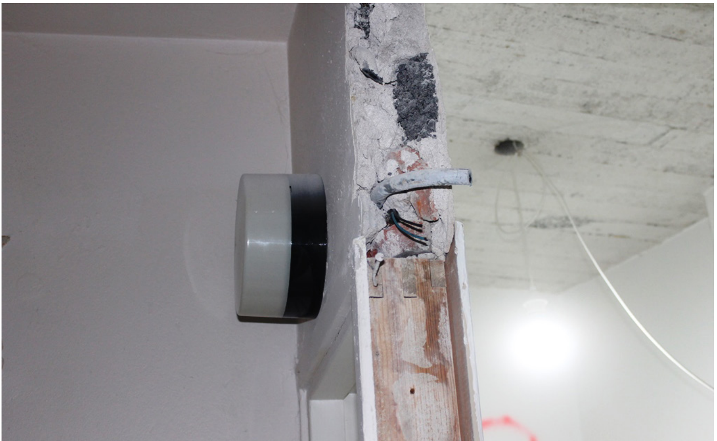
Bergmanin putki rakennustyömaalla.
