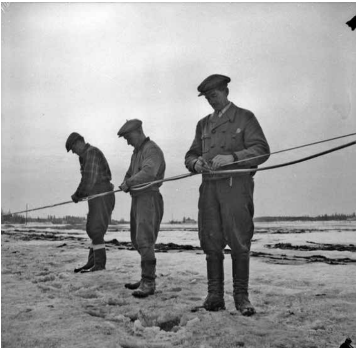
Kaapelityötä Kauvatsalla 1959 - miehet kiinnittävät kaapelia käsin. (Kuvaaja Raimo Seppälä, Satakunnan museo)
